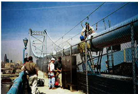
図3 ケーブル上へのAEセンサーの取り付け状況
