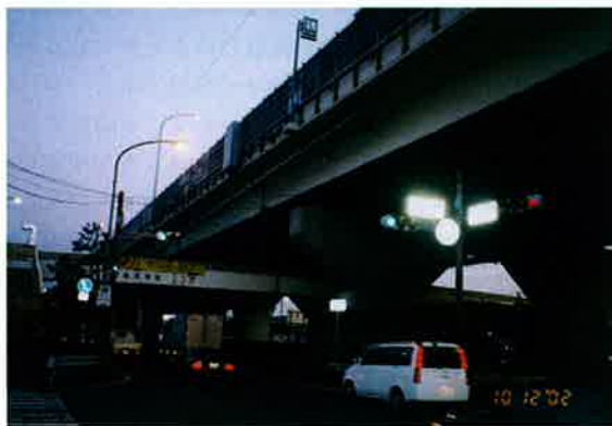
図7 AE連続モニタリングを実施したPC高架橋
