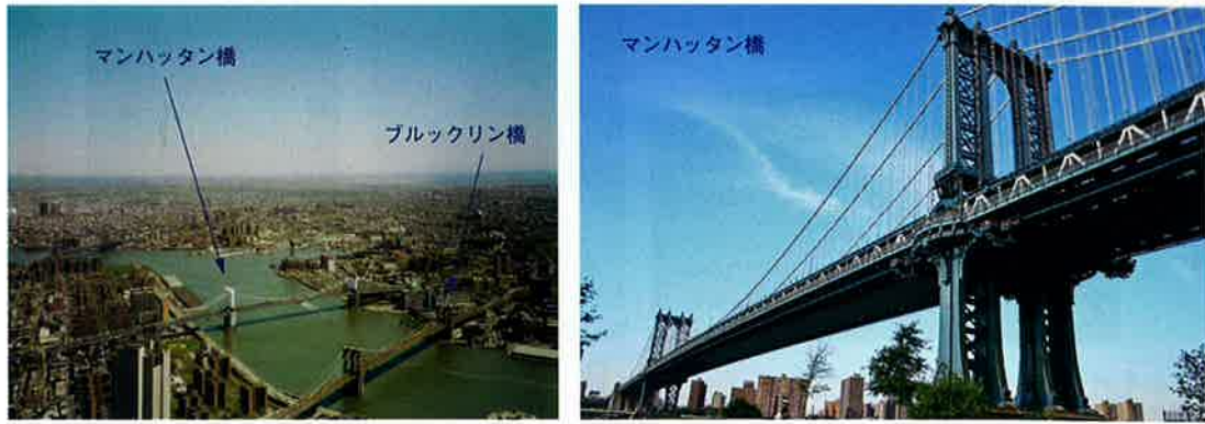
図6 マンハッタン橋における構造物ヘルスマニタリング
