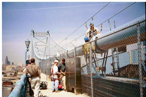
写真-4 ケーブル上への AE センサーの取り付け状況
